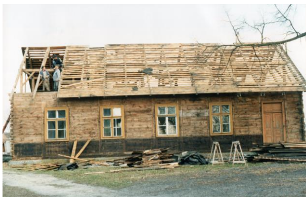
Il. 31. Rozbiórka dachu na starej plebanii (fot. kronika parafii Kanie)
