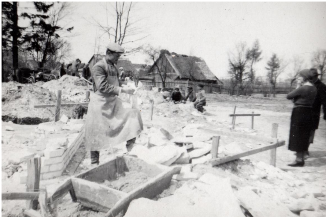
Il. 76. Prace przy fundamentach i podmurówce nowego kościoła w Kaniem (fot. z archiwum G. Wojciechowskiego)
