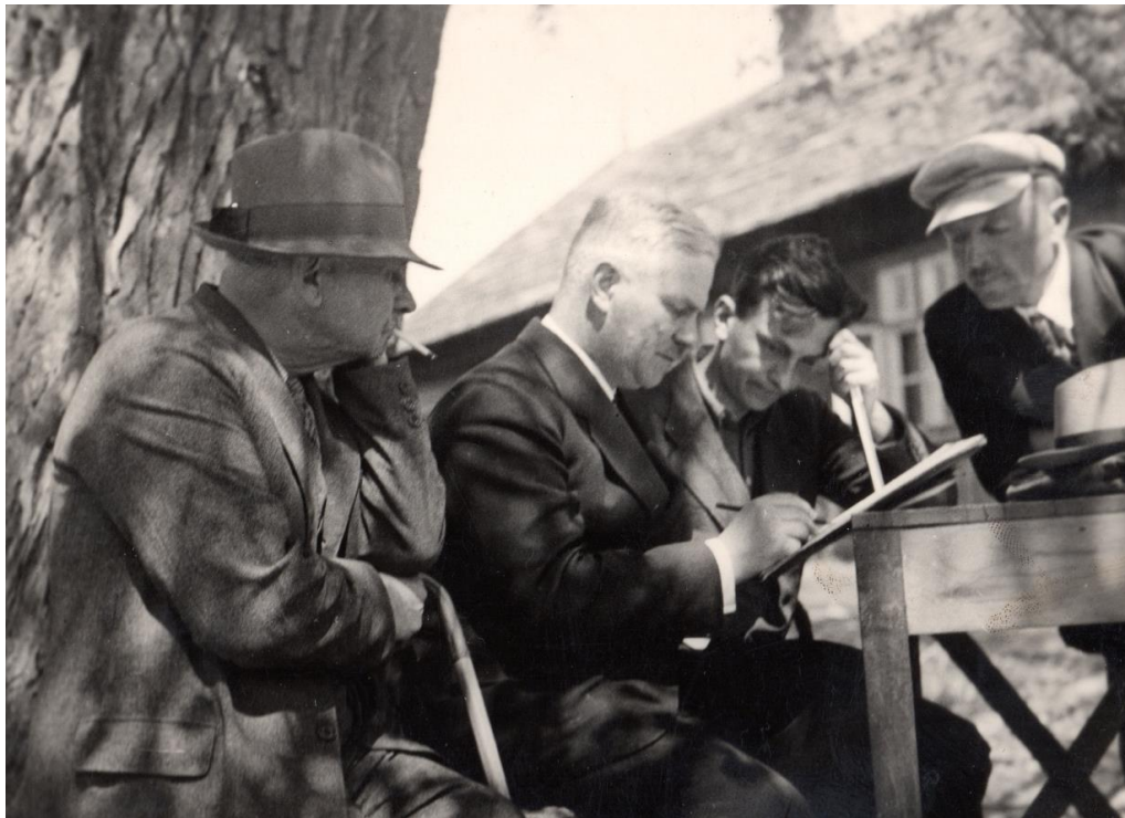
Il. 80. Uzgodnienia w trakcie budowy nowego kościoła w Kaniem, od lewej: Ksawery Wojciechowski, inż. Bogumił Płachecki, Włodzimierz Wojciechowski, p. Rybarczyk, w tle stara plebania (fot. z archiwum G. Wojciechowskiego)
