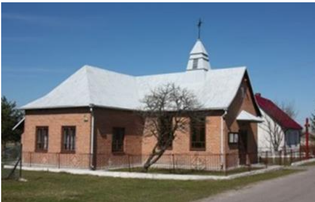
Il. 48. Nowa kaplica w Wólce Kańskiej, stan z 2012 roku (fot. M. Kopniak)
