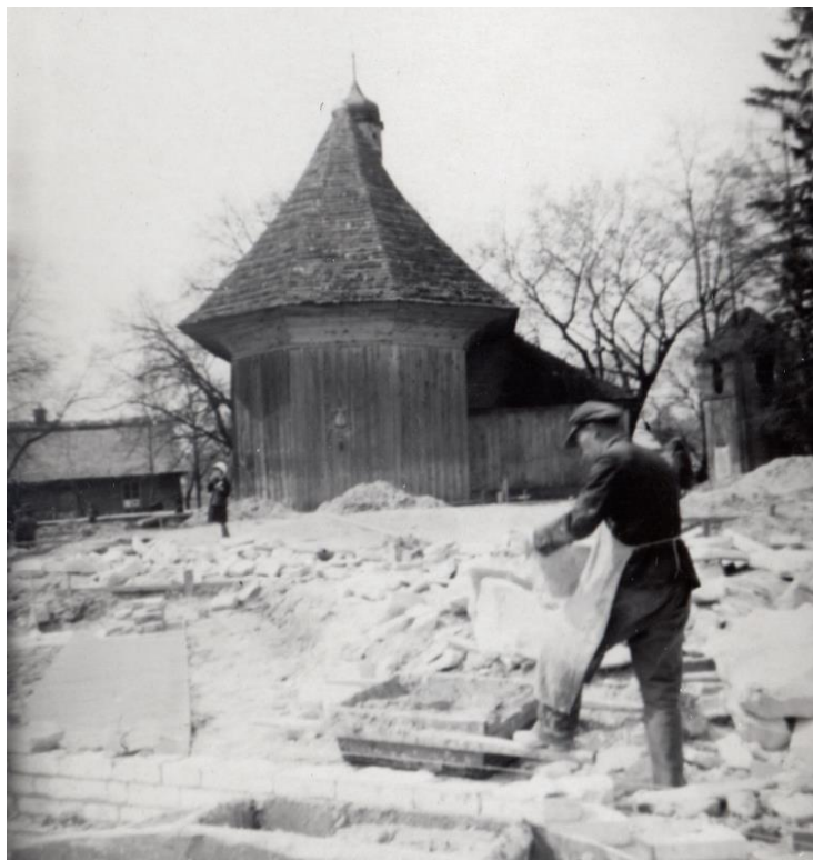
Il. 74. Budowa fundamentów nowego kościoła w Kaniem, w tle stary kościół i po prawej dzwonnica (fot. z archiwum G. Wojciechowskiego)
