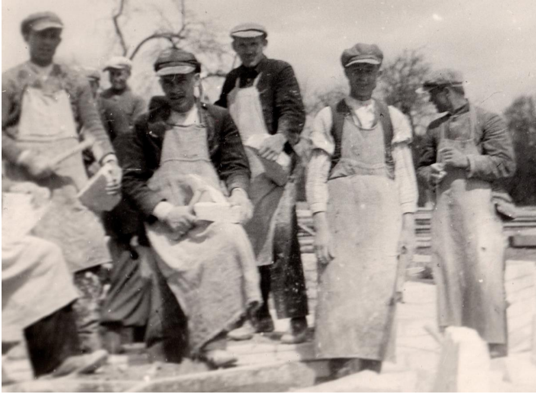
Il. 77. Grupa kamieniarzy pracujących przy budowie fundamentów i podmurówki nowego kościoła w Kaniem (fot. z archiwum G. Wojciechowskiego)
