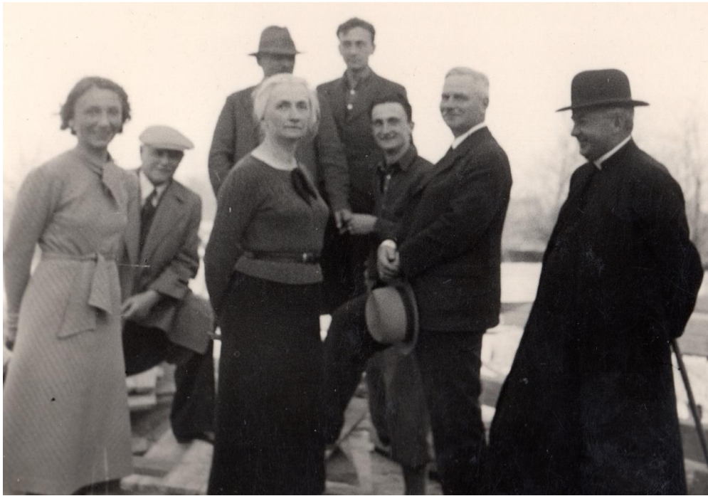
Il. 79. Wizyta rodziny Wojciechowskich na placu budowy nowego kościoła w Kaniem, na pierwszym planie od lewej stoją: Anna Wojciechowska i Zofia Wojciechowska, po prawej stronie w meloniku ks. W. Gosek, na drugim planie od lewej: p. Rybarczyk, Ksawery Wojciechowski, Włodzimierz Wojciechowski, Maciej Wojciechowski, inż. Bogumił Płachecki – architekt (fot. z archiwum G. Wojciechowskiego)
